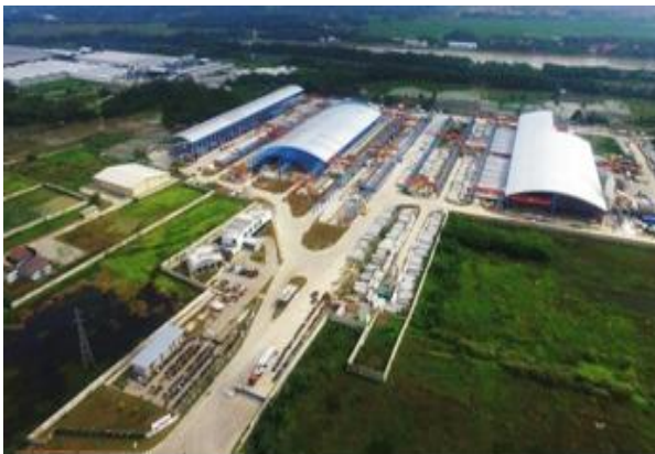
Gambar 1. Fasilitas Produksi Precast
