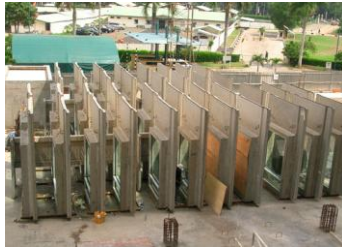
Panel Gedung Precast
